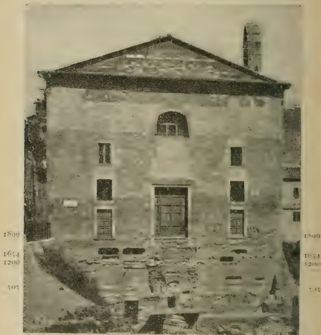
Fig. 53. Façade de la Curie, état actuel.
